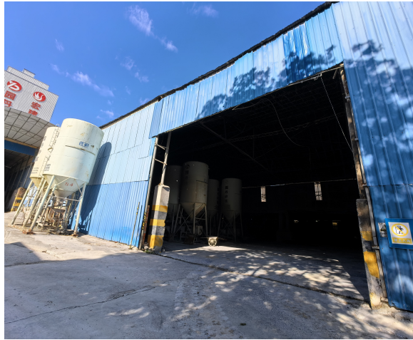
干混砂浆生产车间现状
