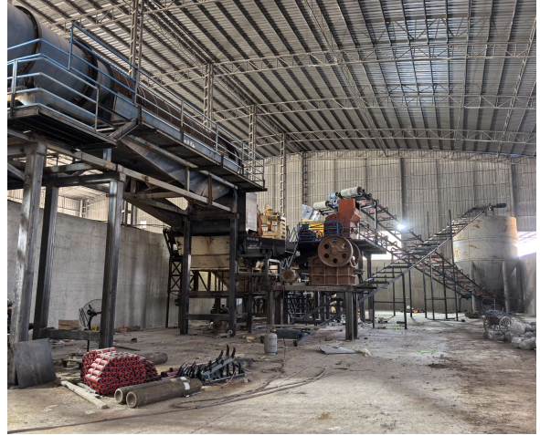
湿法制砂生产车间现状
