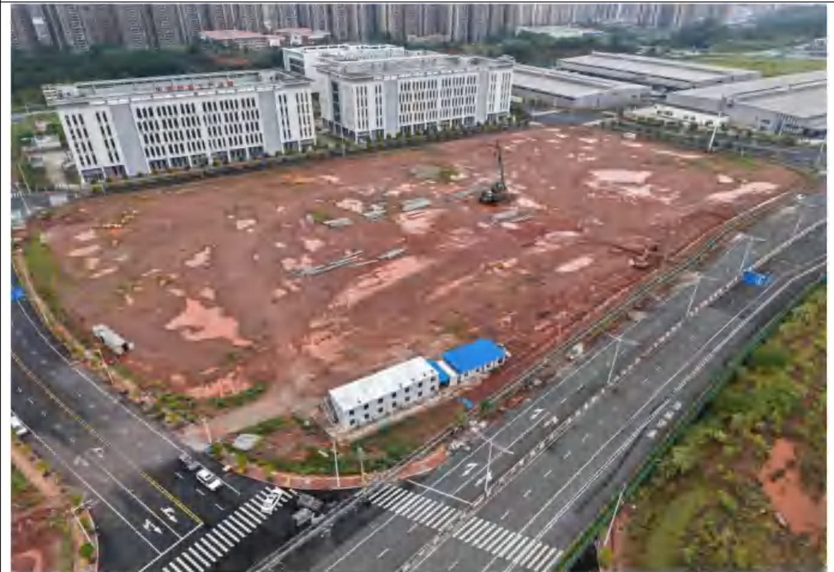
本项目地块二现状航拍1（2025年9月）
