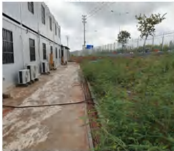
施工生活区现状排水沟
