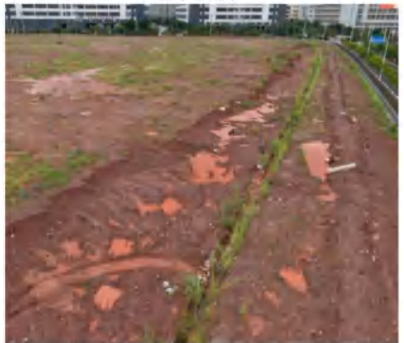
场地周围临时排水沟(土质)
