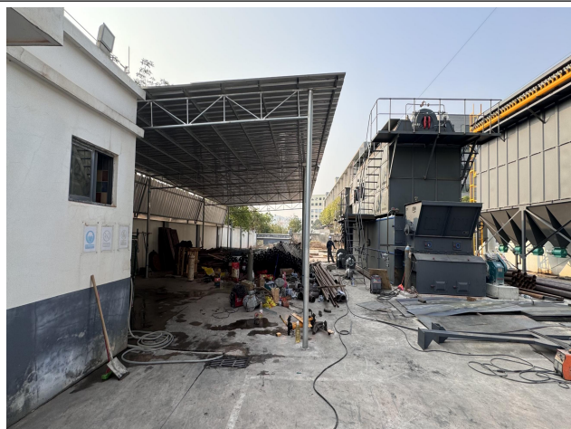
新增 6t/h 生物质锅炉已开始安装的主体设备
