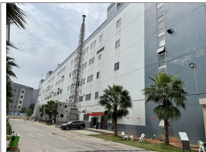
厂区生产车间
