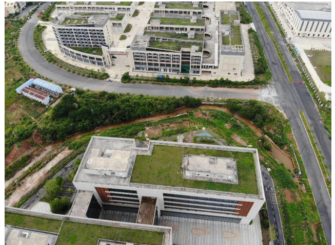
项目北面物流仓库
