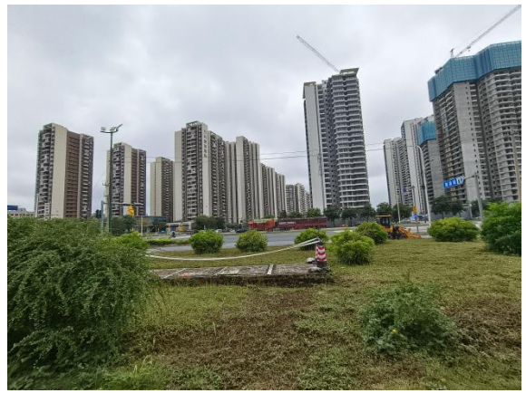
项目南面为平乐大道、隔平乐大道为金科城小区
