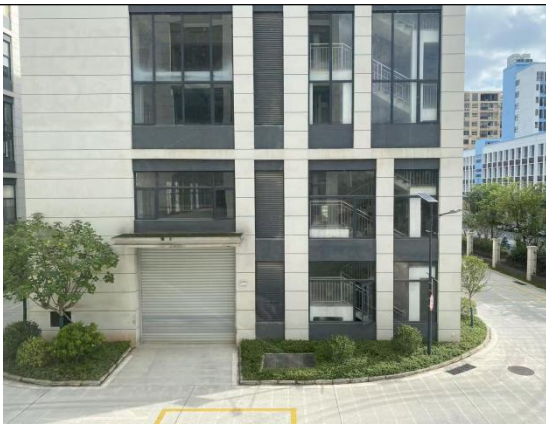
项目南面 12 号楼 101 号厂房
