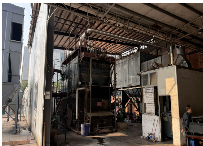
项目原有的 6t/h 燃生物质锅炉
