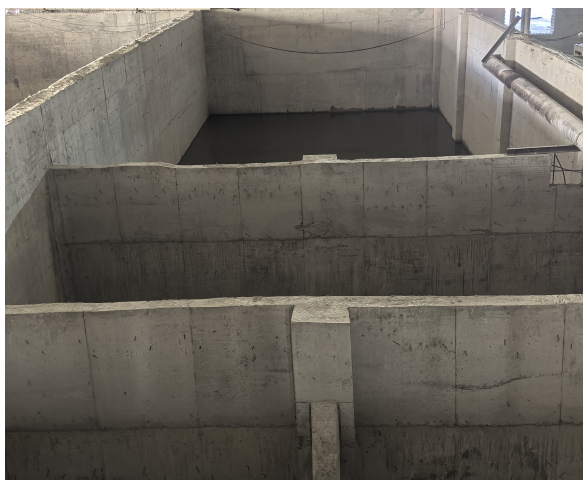
湿法制砂生产线配套沉淀池
