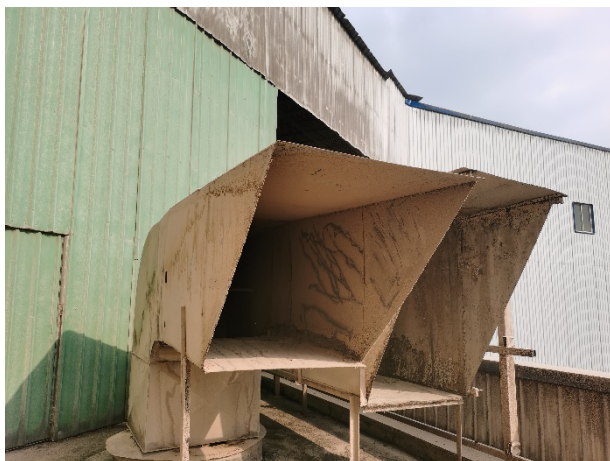
制粒流程排气筒
