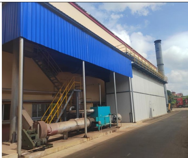
一车间锌锅加热炉房及尾气排气筒
