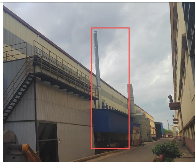
二车间锌锅加热炉房及尾气排气筒
